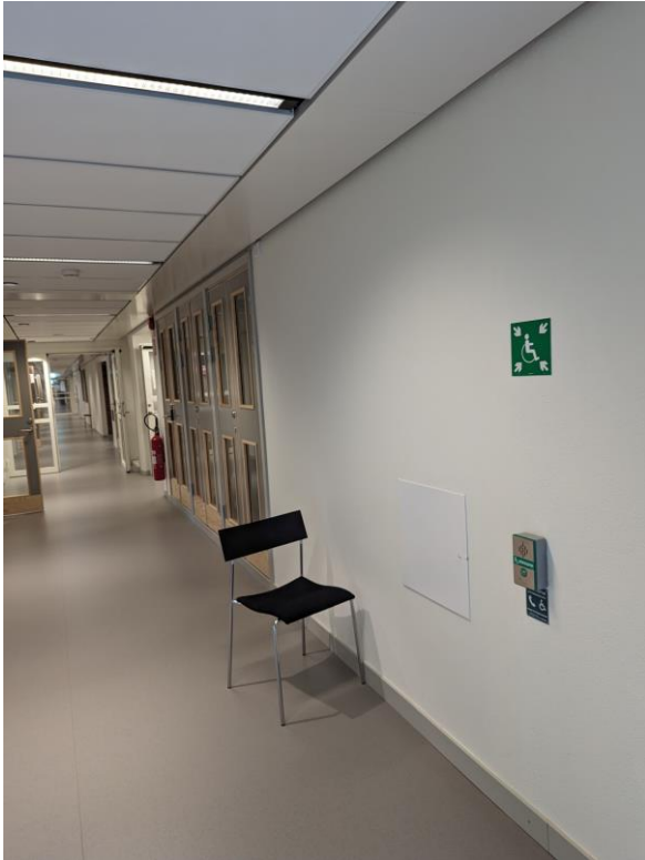
Figur 7.3 – Skylt placerad mot väg
