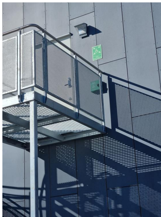
Figur 4.4 – utrymningsplats placerad utomhus på vilplanet till en utrymningstrappa
