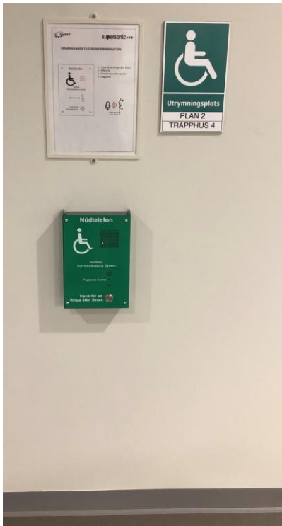
Figur 4.5 – utrymningsplats placerad i en utrymningstrappa
