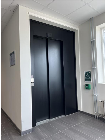
Figur 4.15 – Tvåvägskommunikation placerad för nära inner hörn
