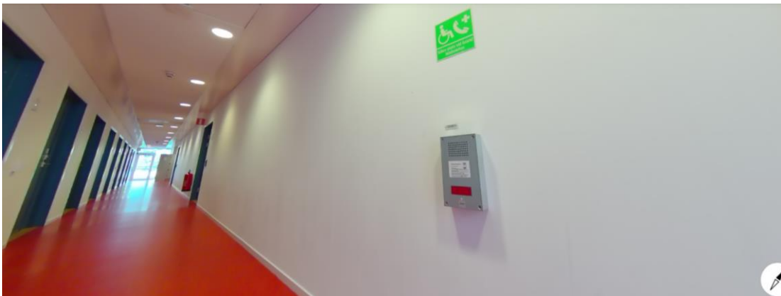
Figur 6.9 – Vy roterad ca 180 grader moturs, utrymningsplats 3.
