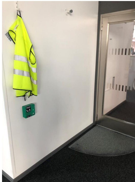
Figur 4.10 – utrymningsplats placerad inom lokalen
