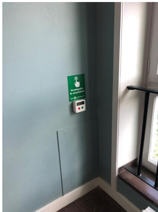
Figur 4.12 – utrymningsplats placerad i en utrymningstrappa
