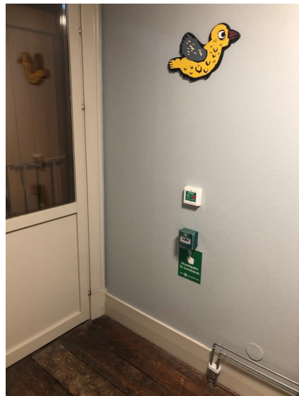
Figur 4.8 – utrymningsplats placerad i en utrymningstrappa
