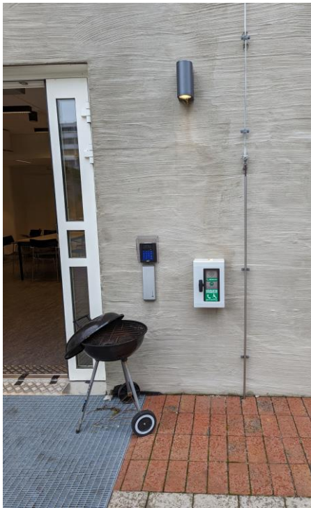
Figur 4.3 – utrymningsplats placerad utomhus på en innergård
