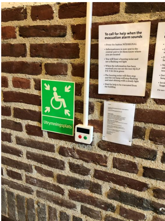
Figur 4.11 – utrymningsplats placerad i en utrymningstrappa
